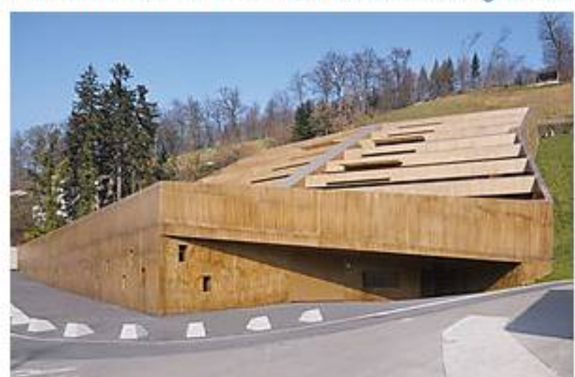
"best architects 15" Award Architektur in unseren Breiten und auf der Höhe der Zeit
