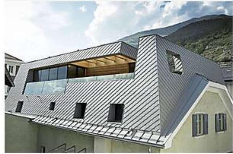
"Presse"-Serie Gut gebaut Dach mit unsichtbarem Innenleben
