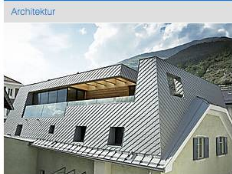
"Presse"-Serie Gut gebaut Dach mit unsichtbarem Innenleben
