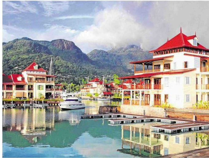
Die Apartments und Villen von Eden Island bieten private Anlegeplätze für Boote und einen schönen Ausblick auf die Berge
