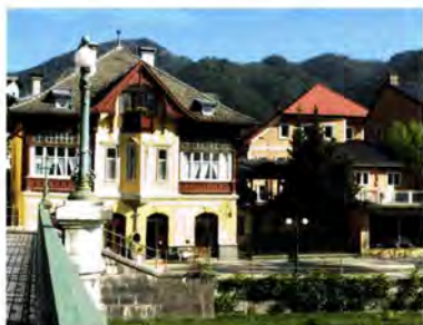
Gute Lage. Entlang der Traun reiht sich in Bad Ischl ein historisches Gebäude an das andere.
